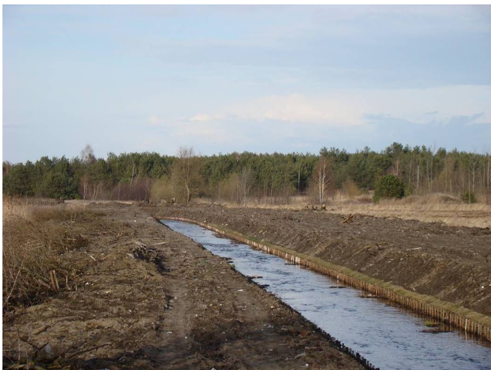
Rzeka Mleczna po wykonaniu prac
