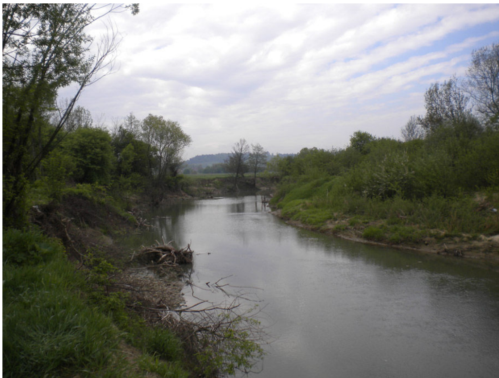
Stradomka przed wykonaniem prac
