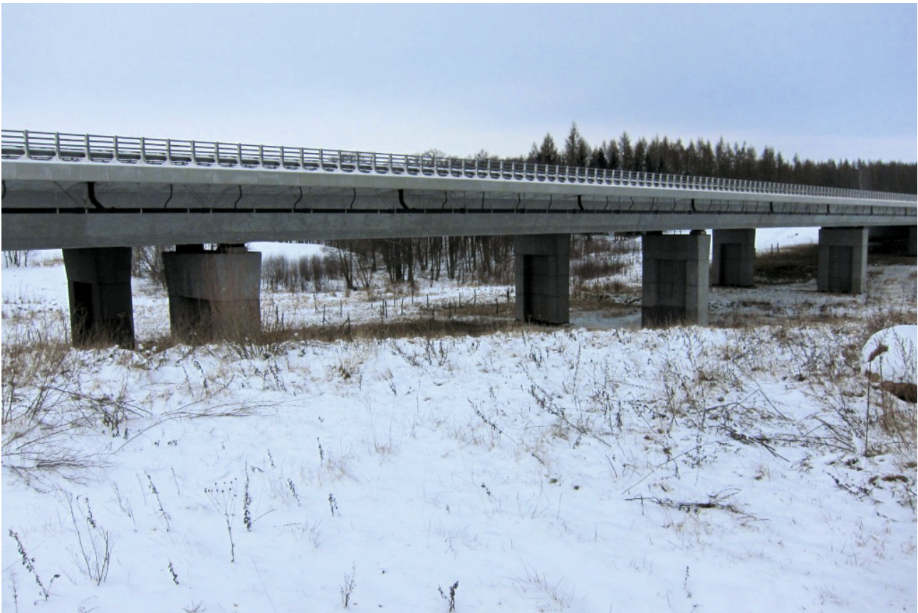
Fot. 12 Wiadukt drogowy nad rzeką Liską
