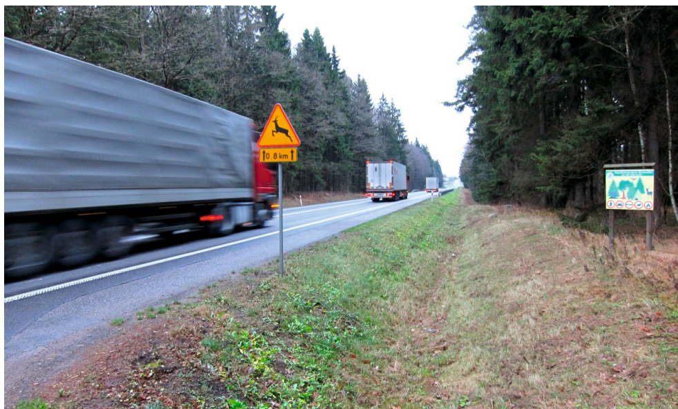
Fot. 3 Istniejąca kolizja między drogą S8 a fragmentem PKE w okolicach miejsowości Szypliszki (fot. T. Podgórski)
