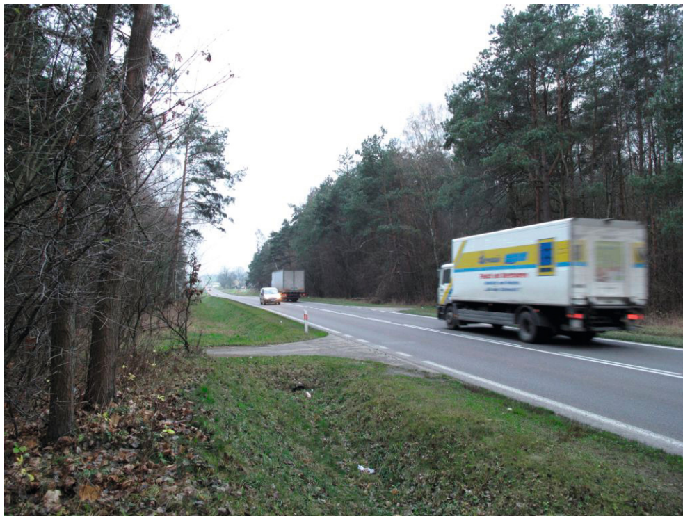
Fot. 9. Stanowisko Obrytki w gm. Szczuczyn. Istniejące miejsce kolizji DK61 z fragmentem Północnego Korytarza Ekologicznego.
