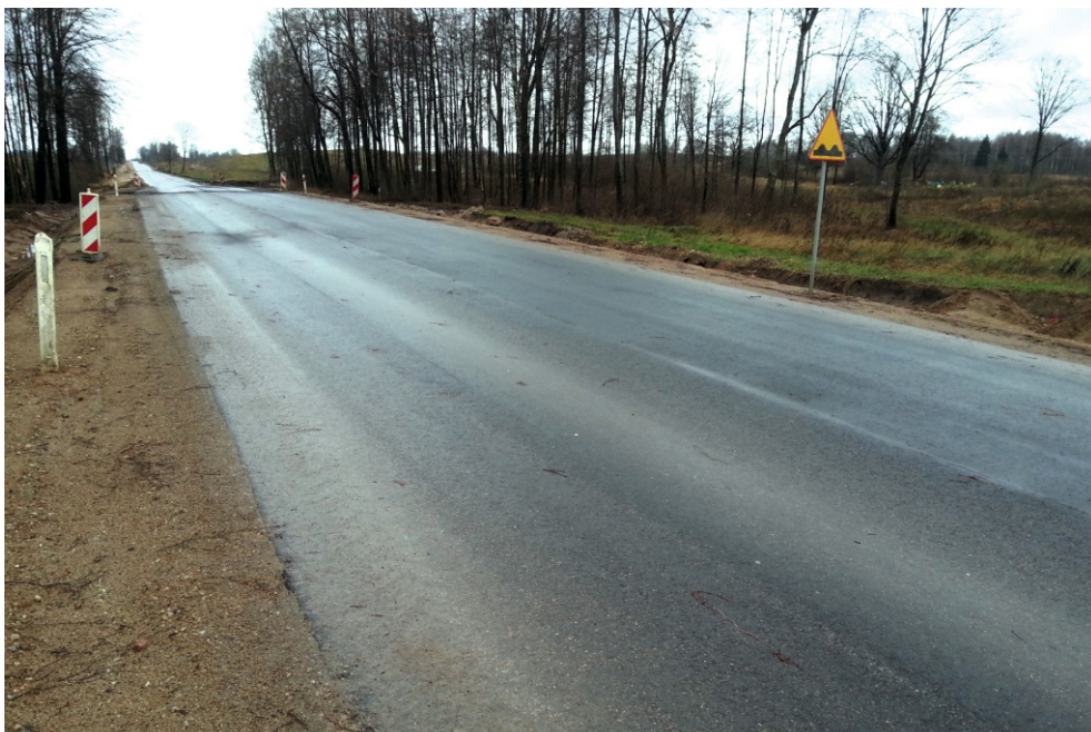
Fot. 4 Stanowisko Kozaki w gm. Gołdap – miejsce kolizji DK65. Konieczne jest wyznaczenie przejścia po powierzchni drogi (fot. T. Podgórski)
