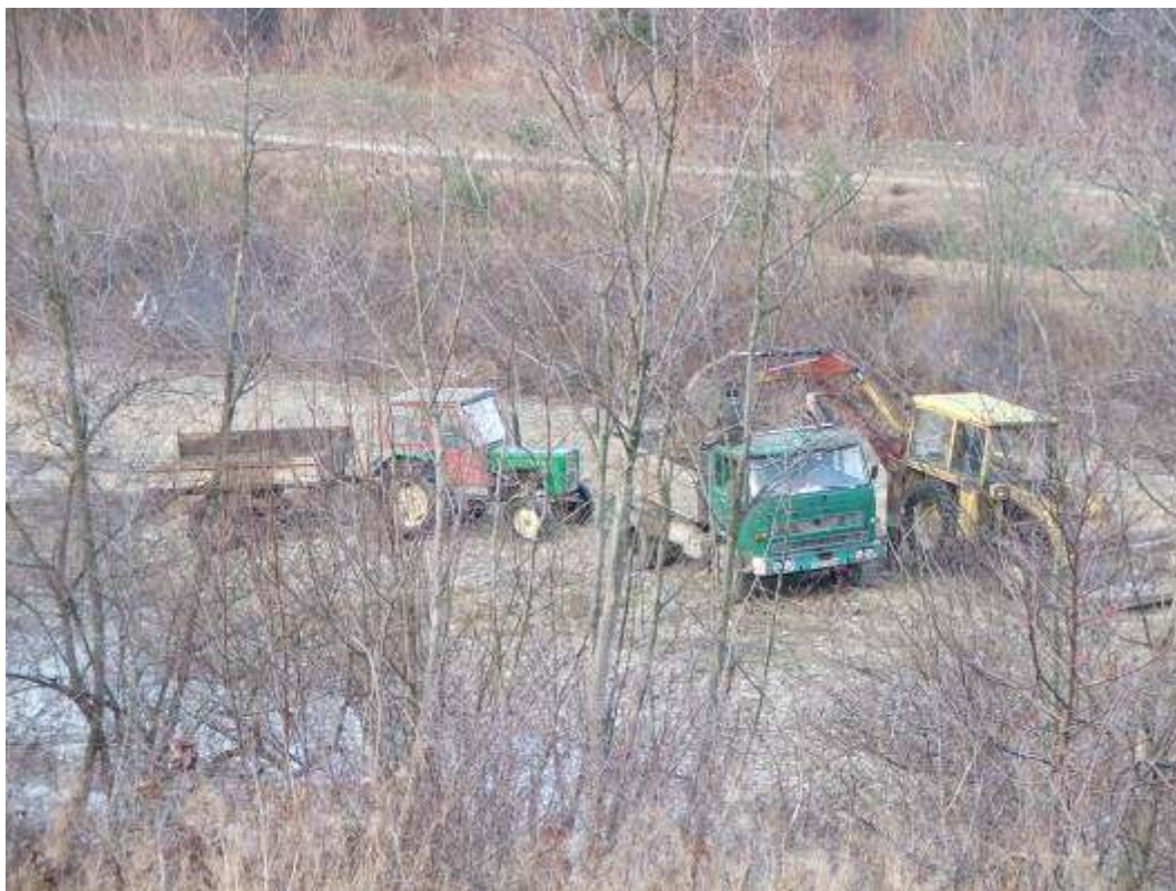
Fot. 35. Listopad 2006. Ciężki sprzęt budowlany pracujący w korycie Białej Tarnowskiej zarybionej łososiem w obszarze Natura 2000 (fot. WWF).
