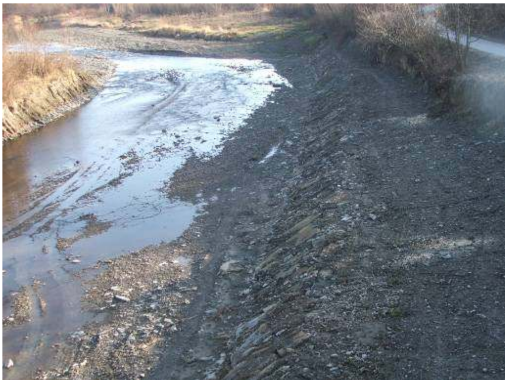
Fot. 37. Listopad 2006. Rozjechane ciężkim sprzętem i całkowicie zniszczone koryto Białej Tarnowskiej na odcinku zarybionym łososiem w obszarze Natura 2000 (fot. WWF).
