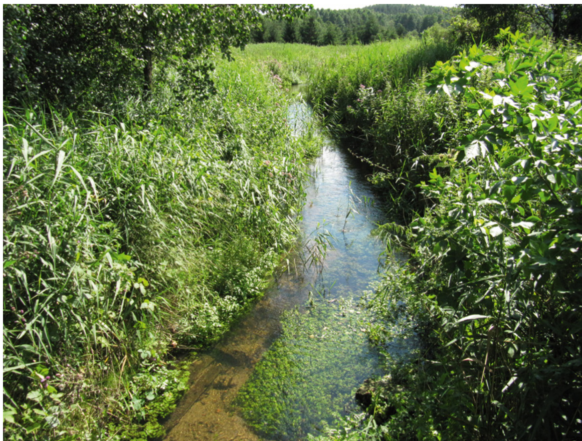
Fot. 13. Roślinność w małym cieku źródłiskowym nie wymagająca ingerencji – pomimo występowania roślinności wodnej i zarośniętych brzegów, przepływ jest szybki i swobodny, a ciek nie stwarza żadnego zagrożenia wezbrańmi (fot. P. Pawlacyk)
