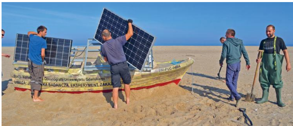
Instalacja nowego punktu wideoobserwacyjnego na Foczej Łasze. Fot. A. Kulasiewicz
