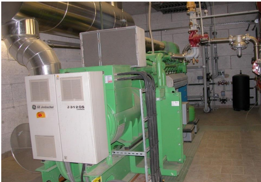
Produkcja energii elektrycznej – silnik kogeneracyjny
