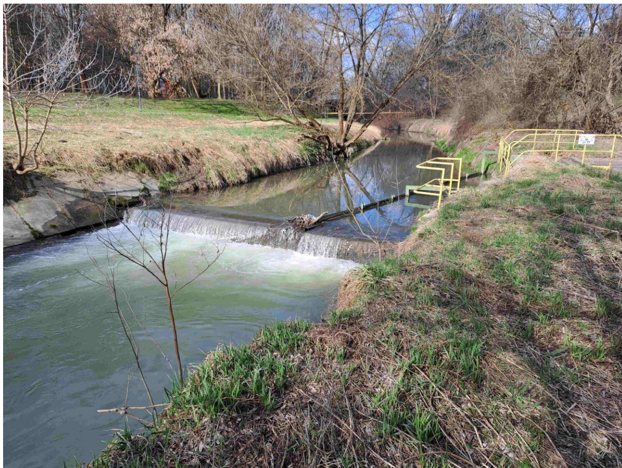
Ujęcie wody PGE, widok z lewego brzegu pod prąd wody
