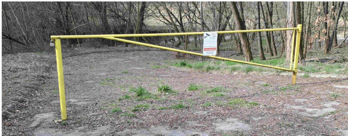
Zjazd z obwałowania w kierunku ujęcia wody PGE, strefa monitorowana, konieczne uzgodnienie dojazdu w rejon ujęcia z PGE
