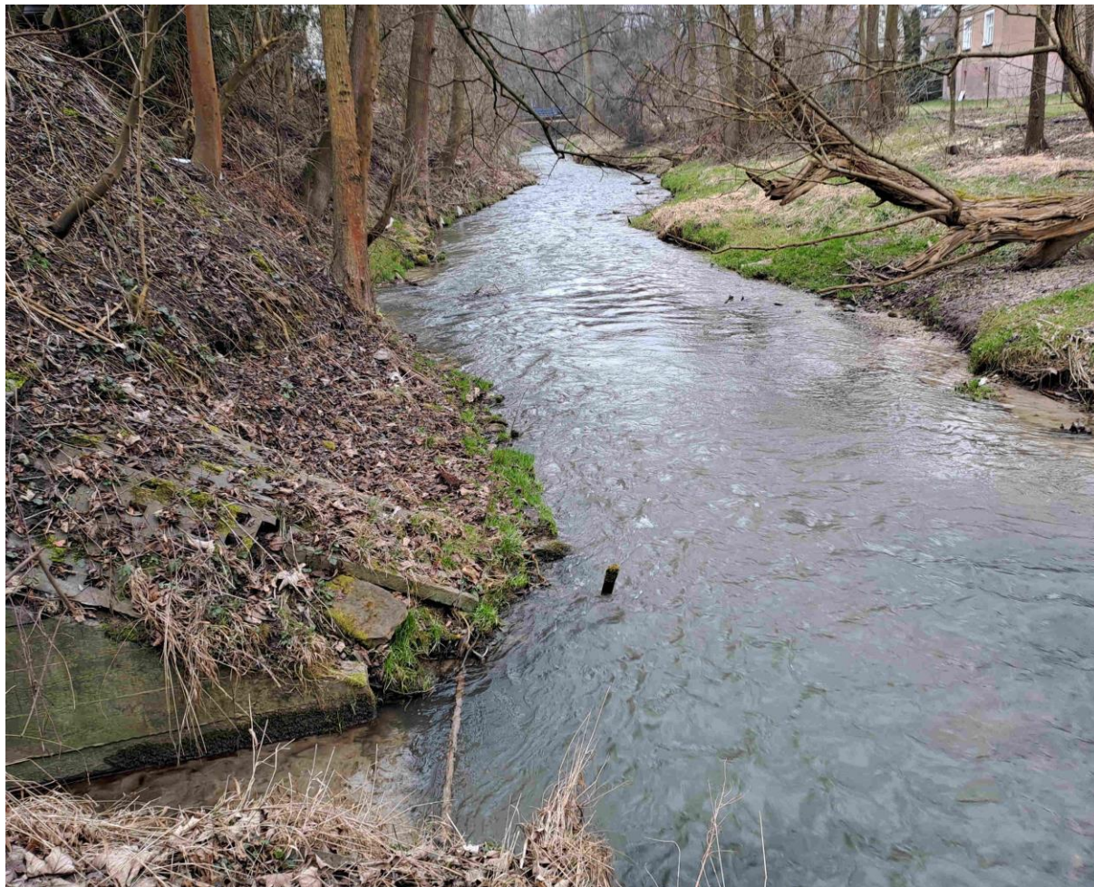
Widok ogólny w dół rzeki Prądnik z poziomu wylotu kolektora, na kładkę powyżej ujścia potoku Sudół w najdalszym planie
