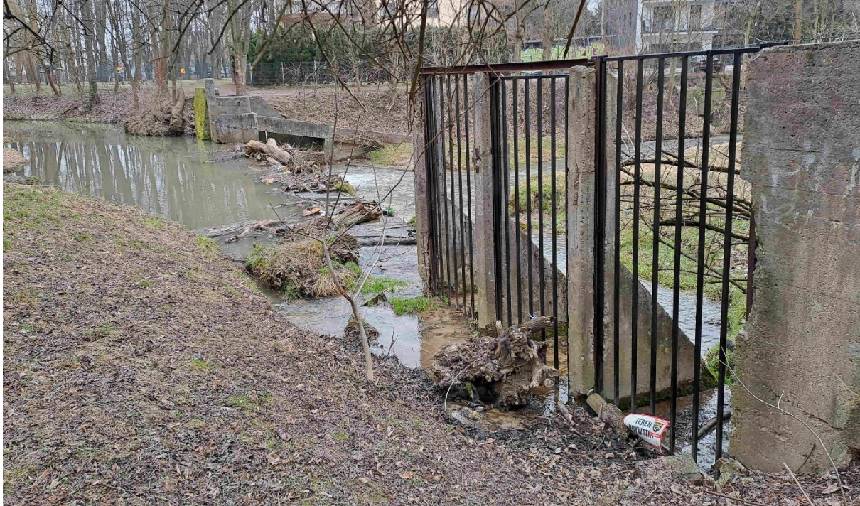
Dawna wysokość jazu - pomiędzy wysokością rusztu na prawym brzegu do najwyższego punktu skrzydła betonowego na lewym brzegu - stopień jest pozostałością podstawy (fundamentu) jazu
